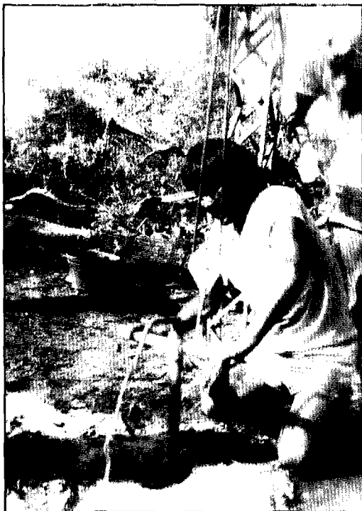
Foto 7: Perforación por aspiración.
