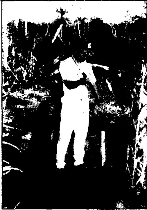
Foto 17: Introducción de la bomba manual al pozo
