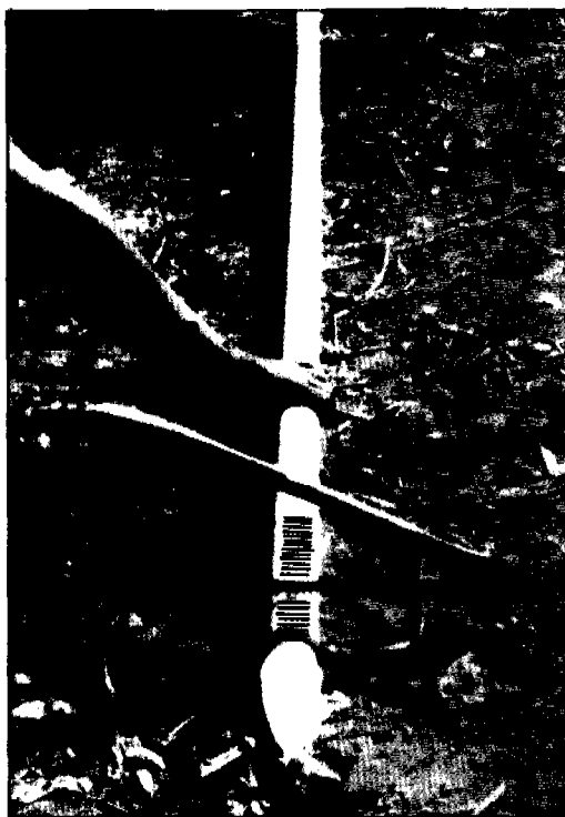
Foto 11: Cortando el filtro.
