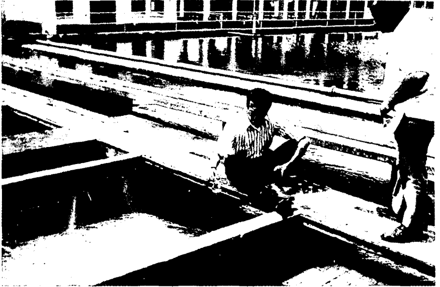
Toma de muestras para análisis de cloruros. Prueba de trazadores en los sedimentadores de la planta de tratamiento de Cali, Colombia.
