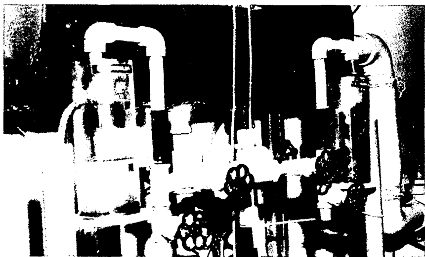
Clarificadores pilotos de la planta de tratamiento de Lima, Perú.
