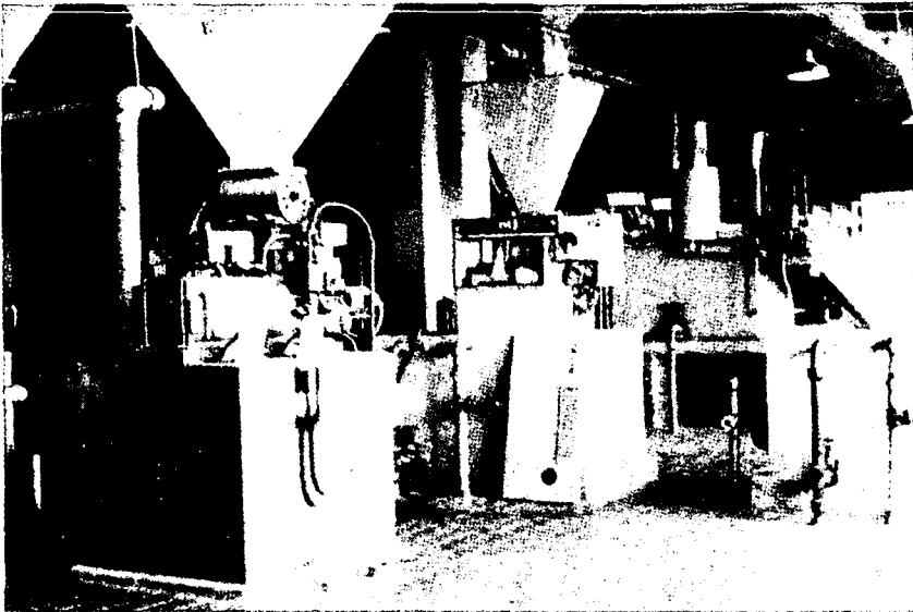
Dosificación de coagulantes en seco. Planta de Tratamiento de Tibitoc, Bogotá, Colombia.
