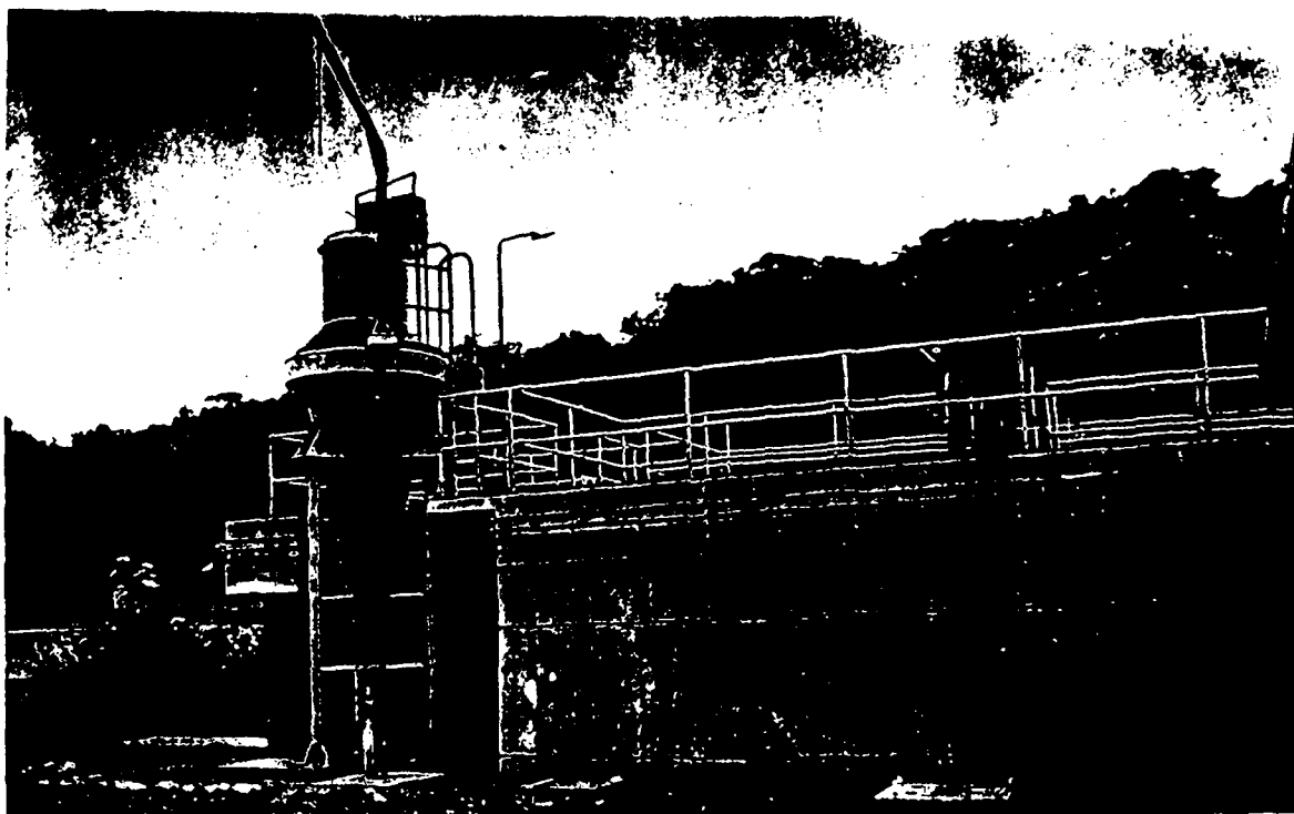
Saturateur de chaux avec bac de délayage au-dessus (Station de BAFILO)
