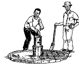
Placez du fil de fer d'armature et un moule pour le trou.
