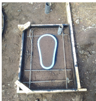
Fig-19: Tie rebar
