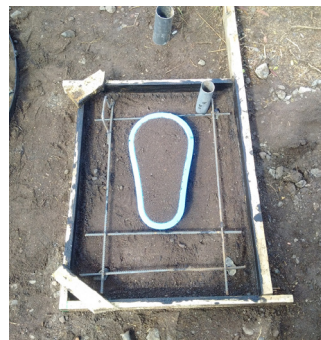
Fig-19: Tie rebar
